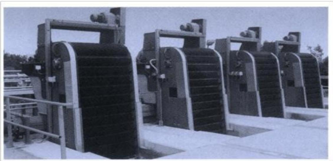
回转式格栅普通由安装在回转链上相隔一定间距的一排排耙齿组成，在驱动装置的驱动下，回转链带动耙齿按一定方向旋转，在迎水面耙齿由下向上运动，将水中飘荡物捞出至顶端翻转后卸下。从使用情况看，在设备质量良好的条件下，运行状况还是比较令人满意的。它的弱点在于对于较大尺寸的飘荡物，如粗大的棍棒、球状物、大块的泡沫塑料或者木块等难以去除，而这些飘荡物在城市污水中是常有的，该型栅格的检修相对而言比较麻烦，虽然它在水下没有传动部件，但由于回转链要通过底部的导棍，有时需要将设备整体吊出才干检修。
