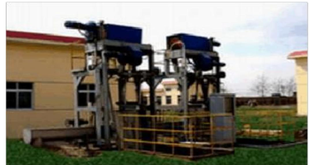
钢索式格栅的栅条是固定的，齿耙由链条带动上下运动，下行时齿耙张开，至格栅底部后闭合，上行时耙齿嵌入栅条，将栅条拦截的飘荡物去除。该型格栅基本可以克服回转式格栅难以去除较大尺寸的飘荡物的弱点。它的弱点是长期运行后，齿耙的两条钢索会产生紧张度不一致而导致齿耙不平，特别在泵房较深时，这个问题比较容易发生。
