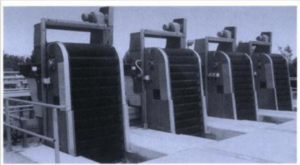
回转式格栅普通由安装在回转链上相隔一定间距的一排排耙齿组成，在驱动装置的驱动下，回转链带动耙齿按一定方向旋转，在迎水面耙齿由下向上运动，将水中飘荡物捞出至顶端翻转后卸下。从使用情况看，在设备质量良好的条件下，运行状况还是比较令人满意的。它的弱点在于对于较大尺寸的飘荡物，如粗大的棍棒、球状物、大块的泡沫塑料或者木块等难以去除，而这些飘荡物在城市污水中是常有的，该型栅格的检修相对而言比较麻烦，虽然它在水下没有传动部件，但由于回转链要通过底部的导棍，有时需要将设备整体吊出才干检修。
