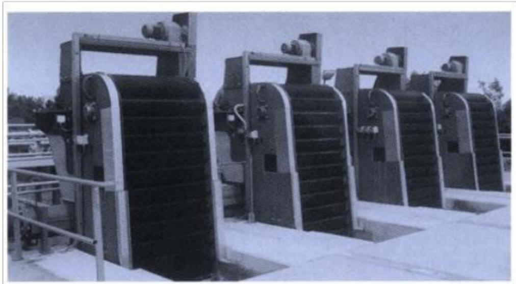
回转式格栅普通由安装在回转链上相隔一定间距的一排排耙齿组成，在驱动装置的驱动下，回转链带动耙齿按一定方向旋转，在迎水面耙齿由下向上运动，将水中飘荡物捞出至顶端翻转后卸下。从使用情况看，在设备质量良好的条件下，运行状况还是比较令人满意的。它的弱点在于对于较大尺寸的飘荡物，如粗大的
